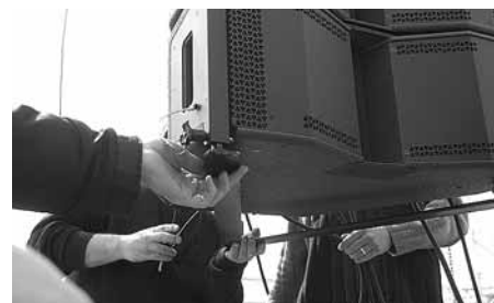
Abbildung 18: Montage des unteren Flugrahmens
