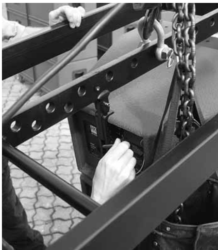
Abbildung 13: Montage des oberen Flugrahmens
